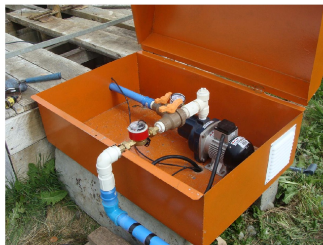
Instalación de Bomba Fotovoltaica
